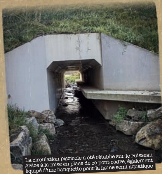
La circulation piscicole a été rétablie sur le ruisseau grâce à la mise en place de ce pont cadre, également équipé d'une banquette pour la faune semi-aquatique
